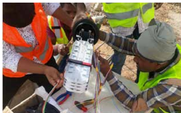
सउदी अरब में एनबीबी परियोजना के तहत ऑप्टिकल फाइबर केबल स्लाइसिंग का कार्य
