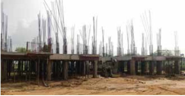
हितौड़ा में नेपाल-भारत मैत्री पॉलीटेक्नीक भवन का निर्माण कार्य
