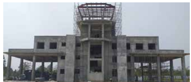
अरुणाचल प्रदेश में तेजू हवाई अड्डे के लिए एटीएस टॉवर भवन का निर्माण
