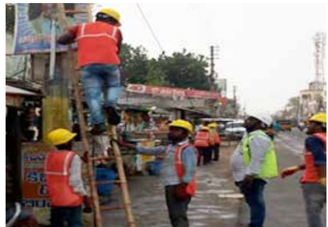
एपीएसएफएल परियोजना में कार्यरत एक टीम द्वारा बिजली के खंभों के साथ एरियल ओएफसी बिछाने का कार्य प्रगति पर
